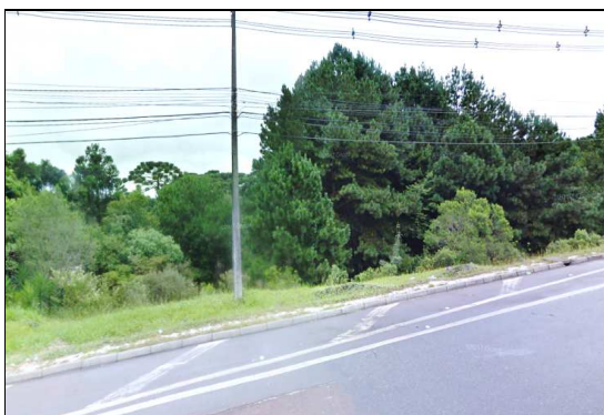
VISTA DA FACHADA DO IMÓVEL EM ESTUDO
